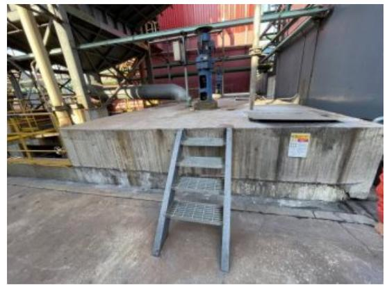
炼铁厂烧结车间石灰水循环池
